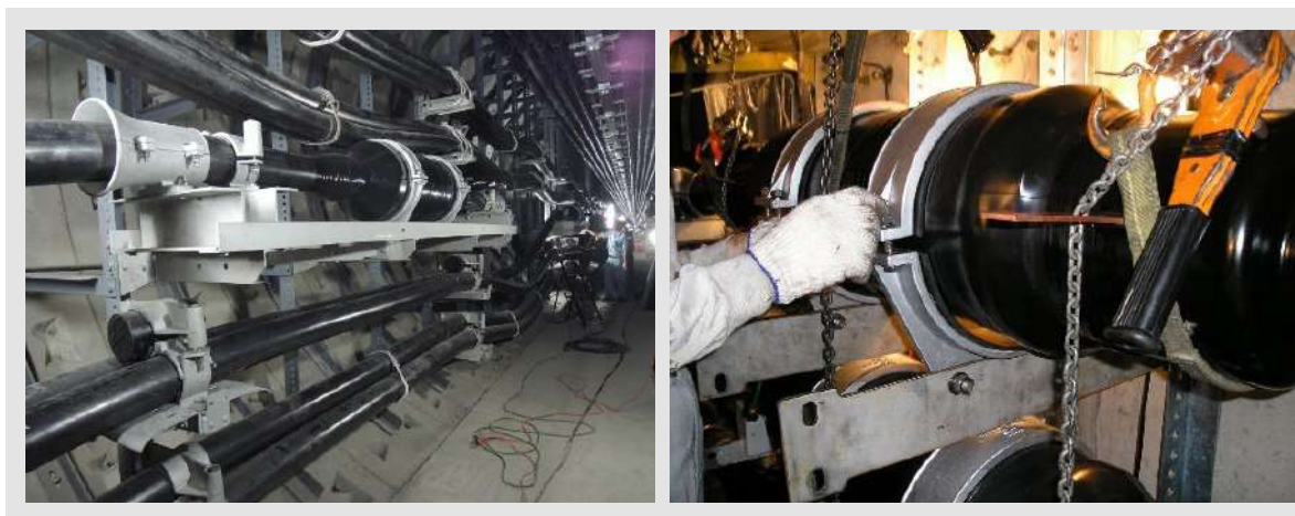
華和工程電纜安裝施工實景
