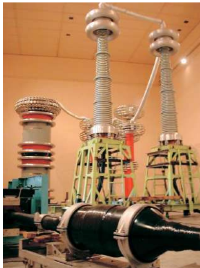
161kV耐電壓試驗
