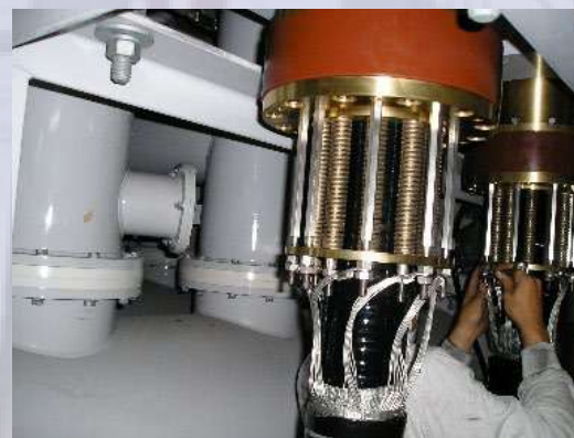
華和工程技師於變電所內進行終端接續組立實景
