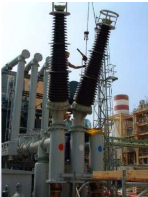
特高壓變電所屋外施工
