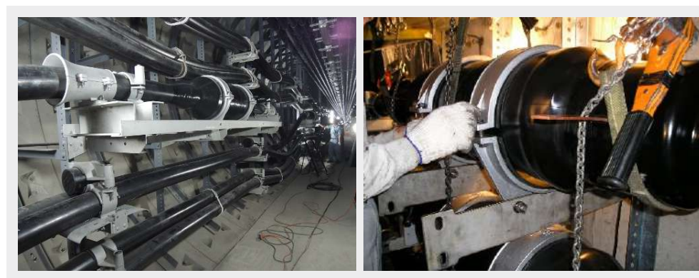
華和工程電纜安裝施工實景
