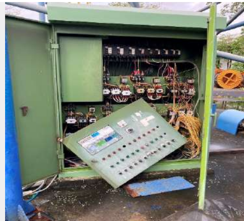
冷卻水塔電氣箱受損
