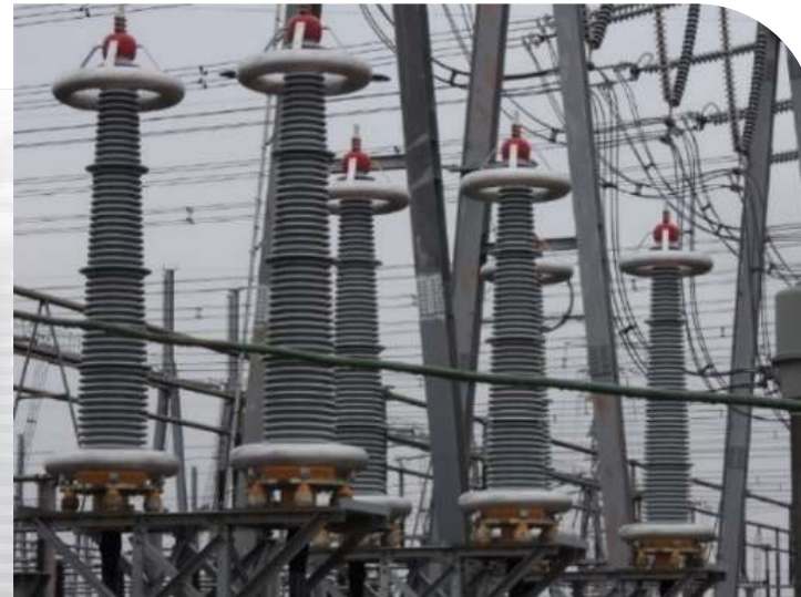
特高壓變電所屋外型終端絕緣礙管組立完工實景
