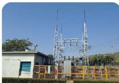
排定ABS空斷開關、新增HVD電壓感知器、7只DS隔離開關、PT比壓器等，於廠區計畫保養期間停電更新
