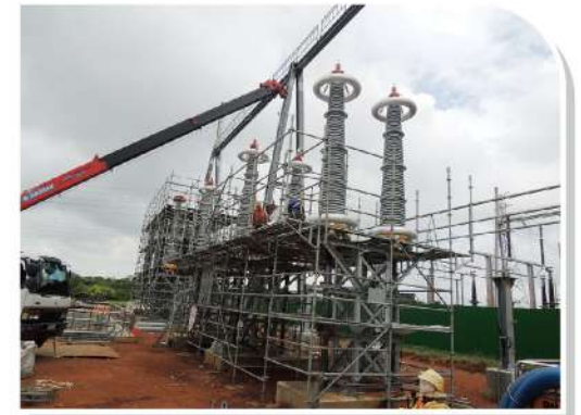
林口345kV特高壓變電所屋外施工
