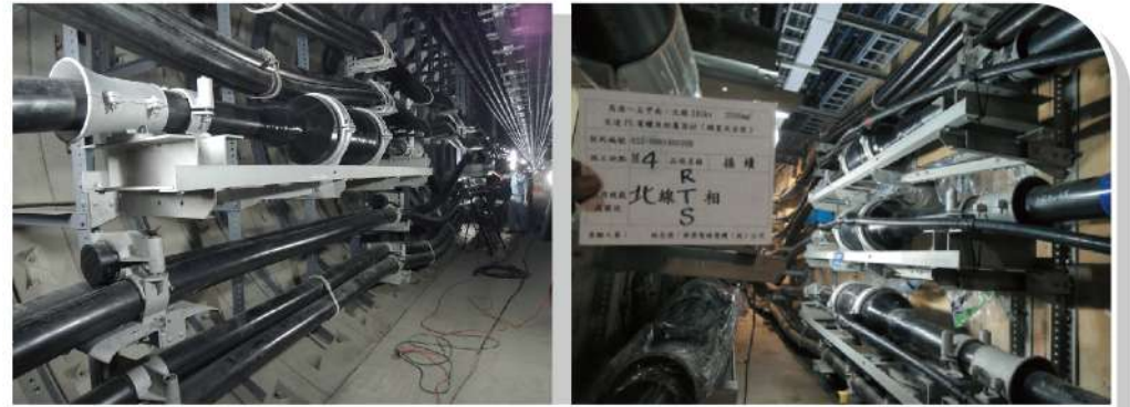
華和工程電纜安裝施工實景
