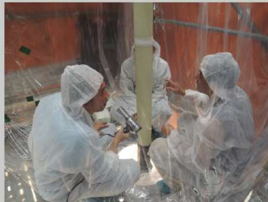
華和工程技師於變電所內進行終端接續組立實景
