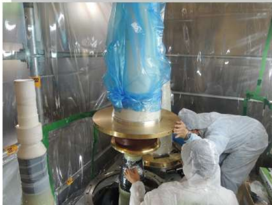
華和工程技師於變電所內進行終端接續組立實景
