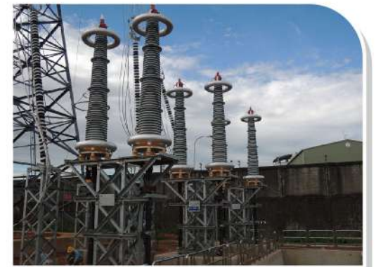
特高壓變電所屋外型終端絕緣礙管組立完工實景
