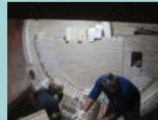
熔銅爐新爐磚構築
