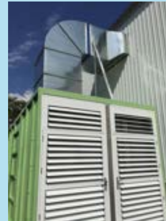
噴漆集塵外部設置改善
