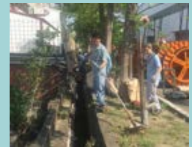
員工排水溝渠清理
