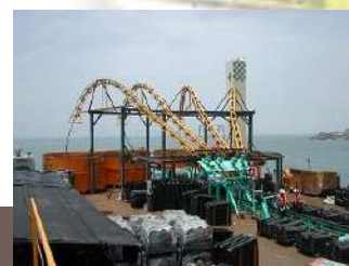
● 佈纜船施放海底電纜
