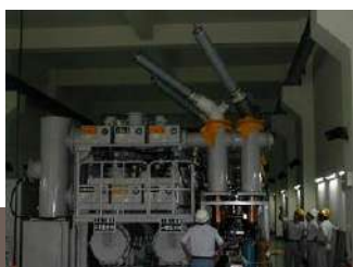
● 變電所端末機電工程
